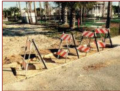
Pour Site Ready for Cement
